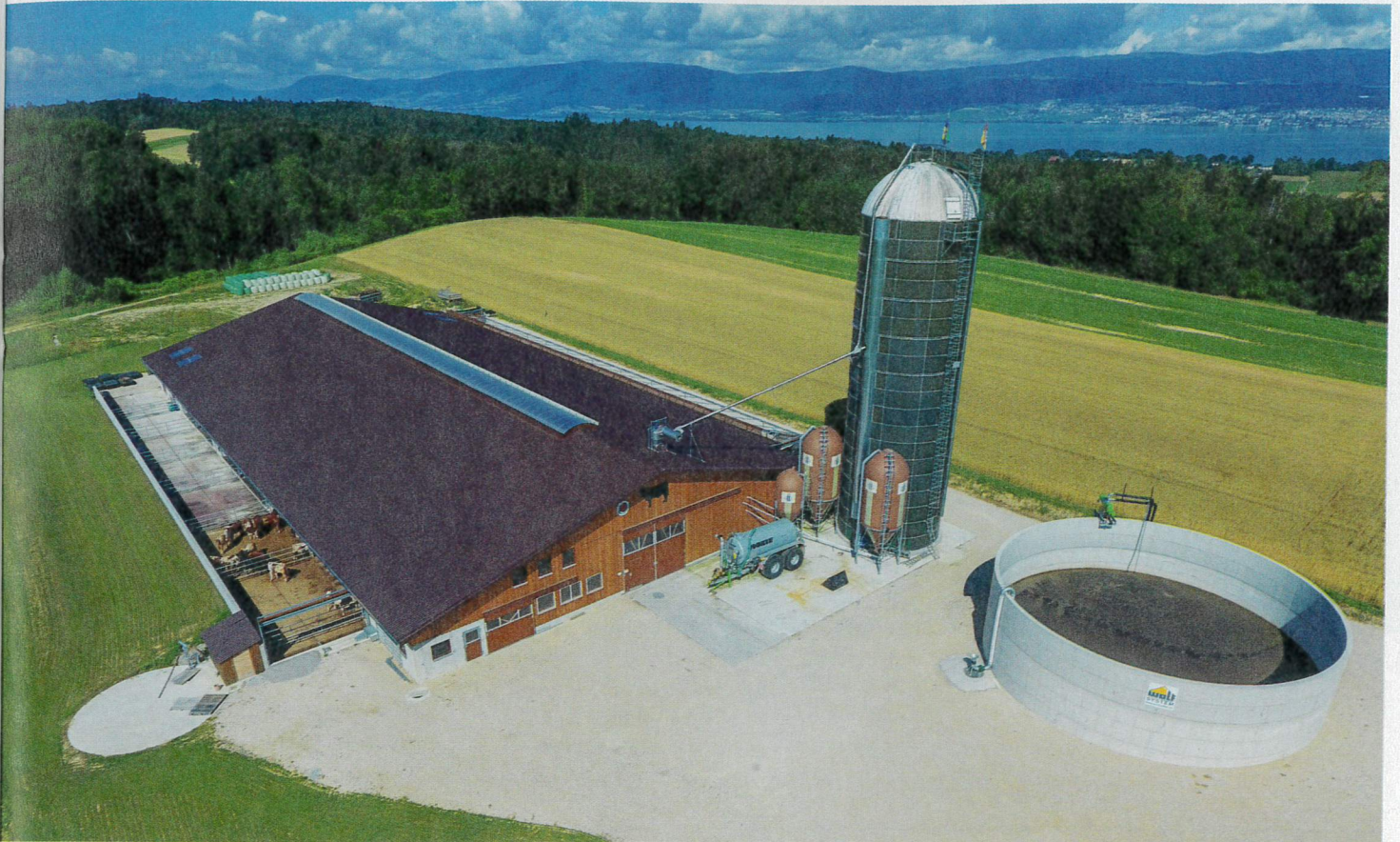
A gauche du bâtiment se trouve une préfosse avec une dalle en béton dessus. Cette dalle, carrossable, a une ouverture pour une grille et une ouverture pour le brasseur. La fosse principale a été construite en hors-sol. Photo: System Wolf
