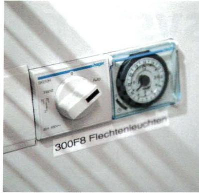
Die UVC-Lampen sind nur nachts eingeschaltet und werden automatisch über eine Zeitschaltuhr gesteuert.
