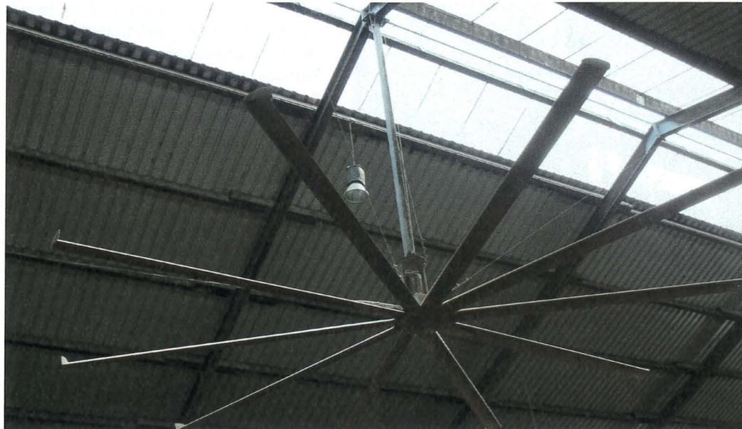
Dieser Ventilatorentyp benötigt durch seine Bau- und Wirkungsweise entsprechend viel Platz und wird deswegen in der Regel zentral über dem Futtergang installiert. Eine Anordnung über den Liegebereich wäre zwar wünschenswerter, ist aber aufgrund der örtlichen Gegebenheiten oft nicht umsetzbar.
