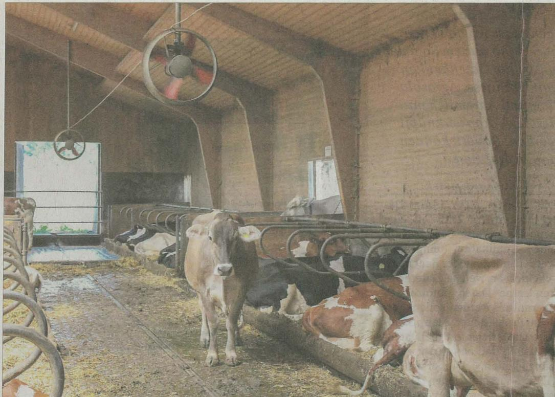
In Milchviehställen sollte das Luftvolumen jede Minute einmal vollständig ausgetauscht werden. Wo das nicht mit baulichen Massnahmen erreicht werden kann, hilft ein Lüfter. (Bild: ats)
