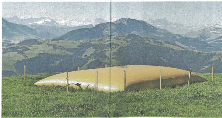
A plus de 1500 m d'altitude, cette citerne a une contenance de 50 m 3 .
