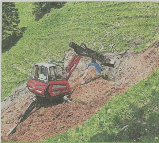
Les aménagements nécessitent parfois de gros travaux dans les pâturages...
