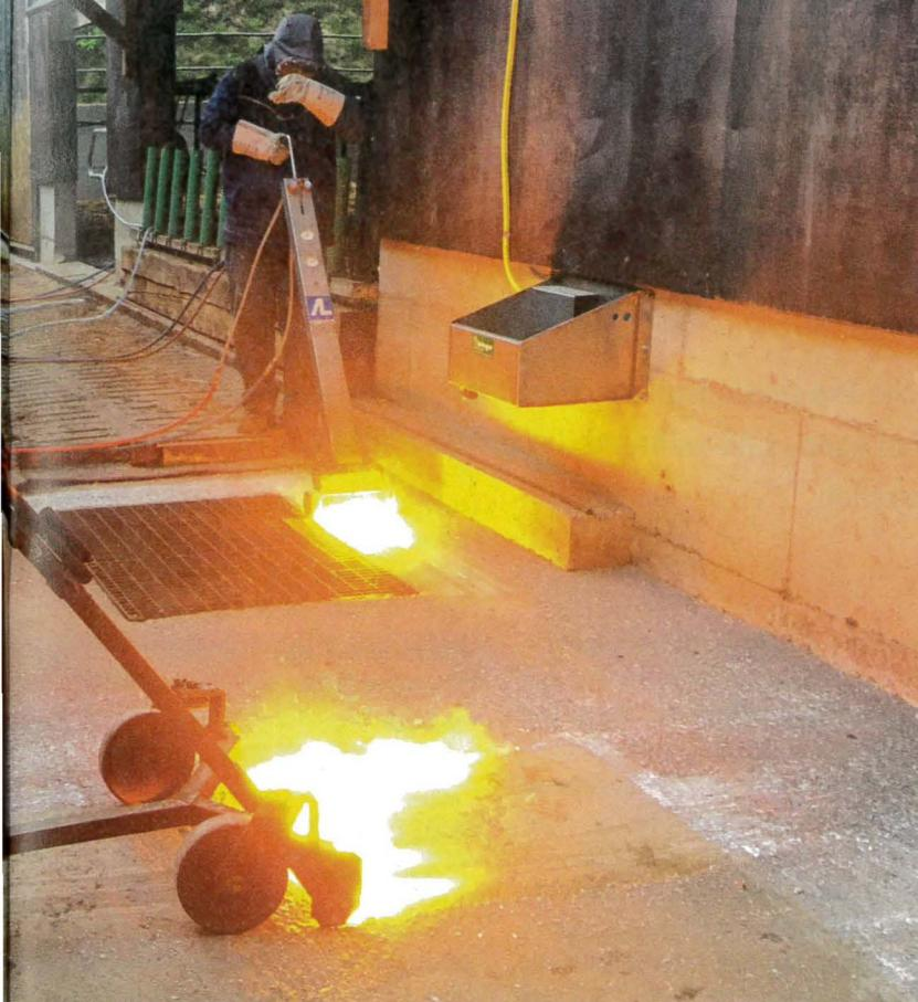
Beim Flammstrahl-Verfahren werden die Böden mit über 3000 °C heißen Flammen bearbeitet, um die Rutschfestigkeit wieder herzustellen. Bild: zVg
