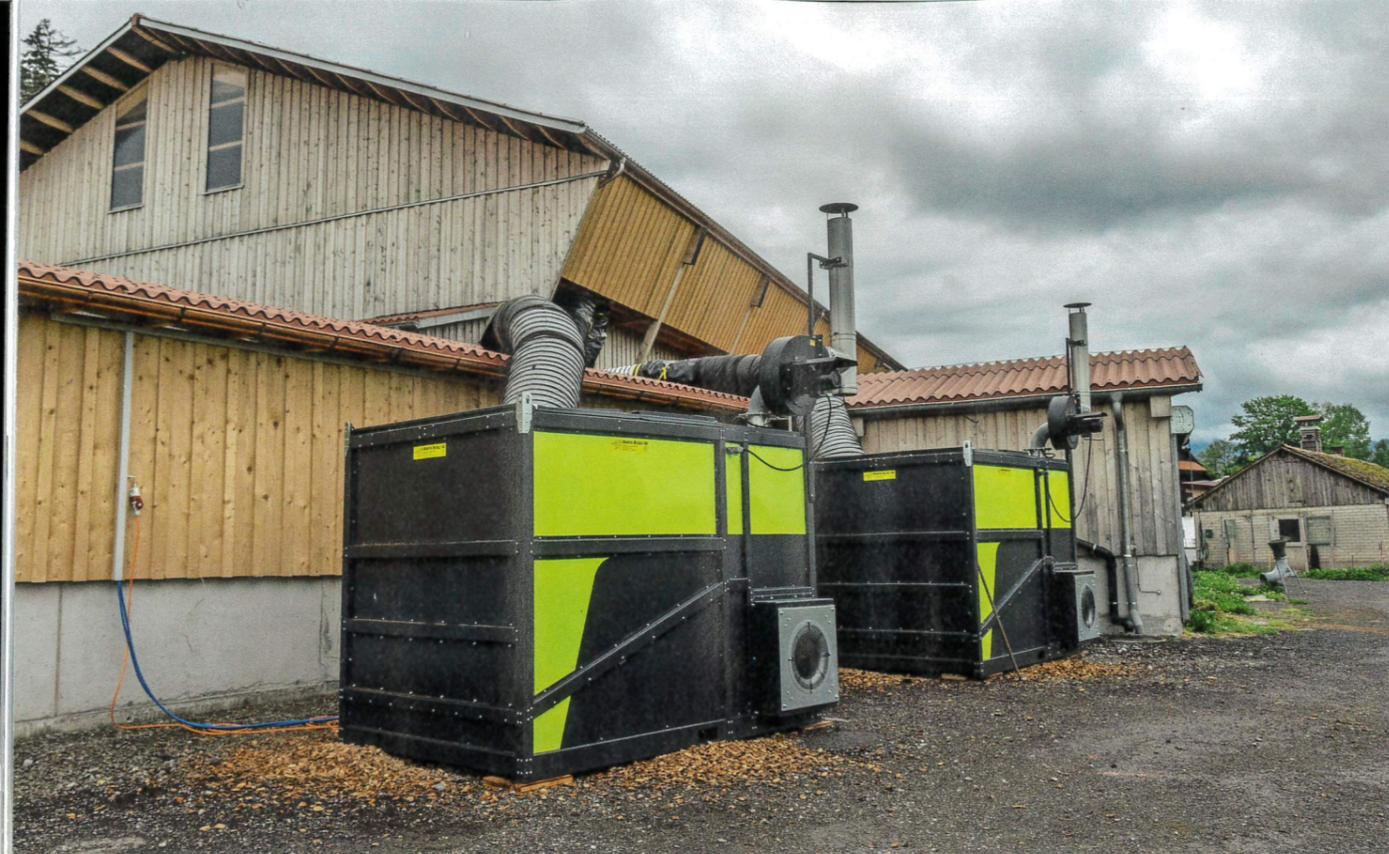
Die Holzschnitzelöfen ermöglichen eine effiziente Heutrocknung bei Schlechtwetter. Die Temperatur wird automatisch reguliert, damit die in den Heustock geblasene Luft maximal 42 Grad warm ist. Je mehr Wärme vom Dach kommt, desto weniger heizen die Öfen.
