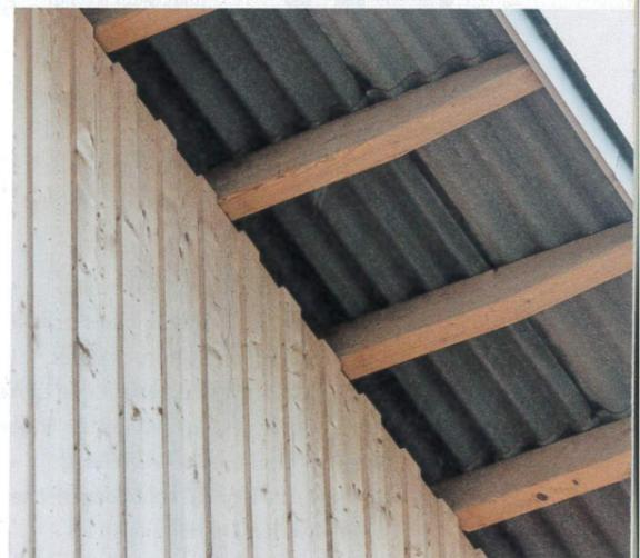
Beim Unterdach wird die Luft stirnseitig angezogen und erwärmt sich.
