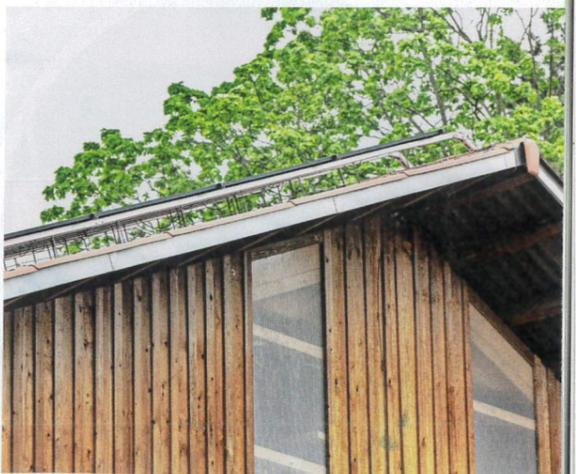
Doppelnutzen: zwischen Solarpanels und Dach erwärmt sich die Luft zur Belüftung.
