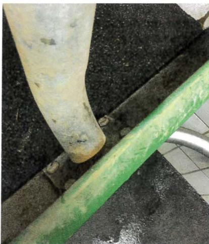
An nicht isolierten Rohrkonstruktionen können Leiterschlaufen entstehen.
