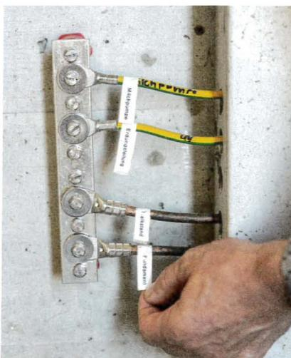
Lösung: isolierte Erdungssammelschiene und zugleich zentraler Erdungspunkt.
