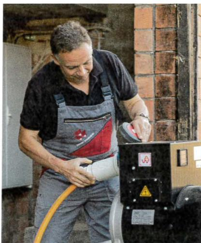
Ursache: zusammengeführte Stromkreise von Wohnhaus und Stall zum Notstromaggregat.
