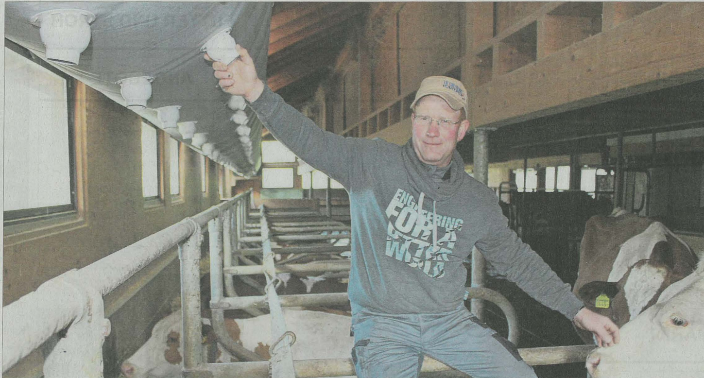
Florian Wegmüller zeigt die verstellbaren Öffnungen. Frischluft strömt direkt an die liegende Kuh. (Bilder: Adrian Haldimann)
