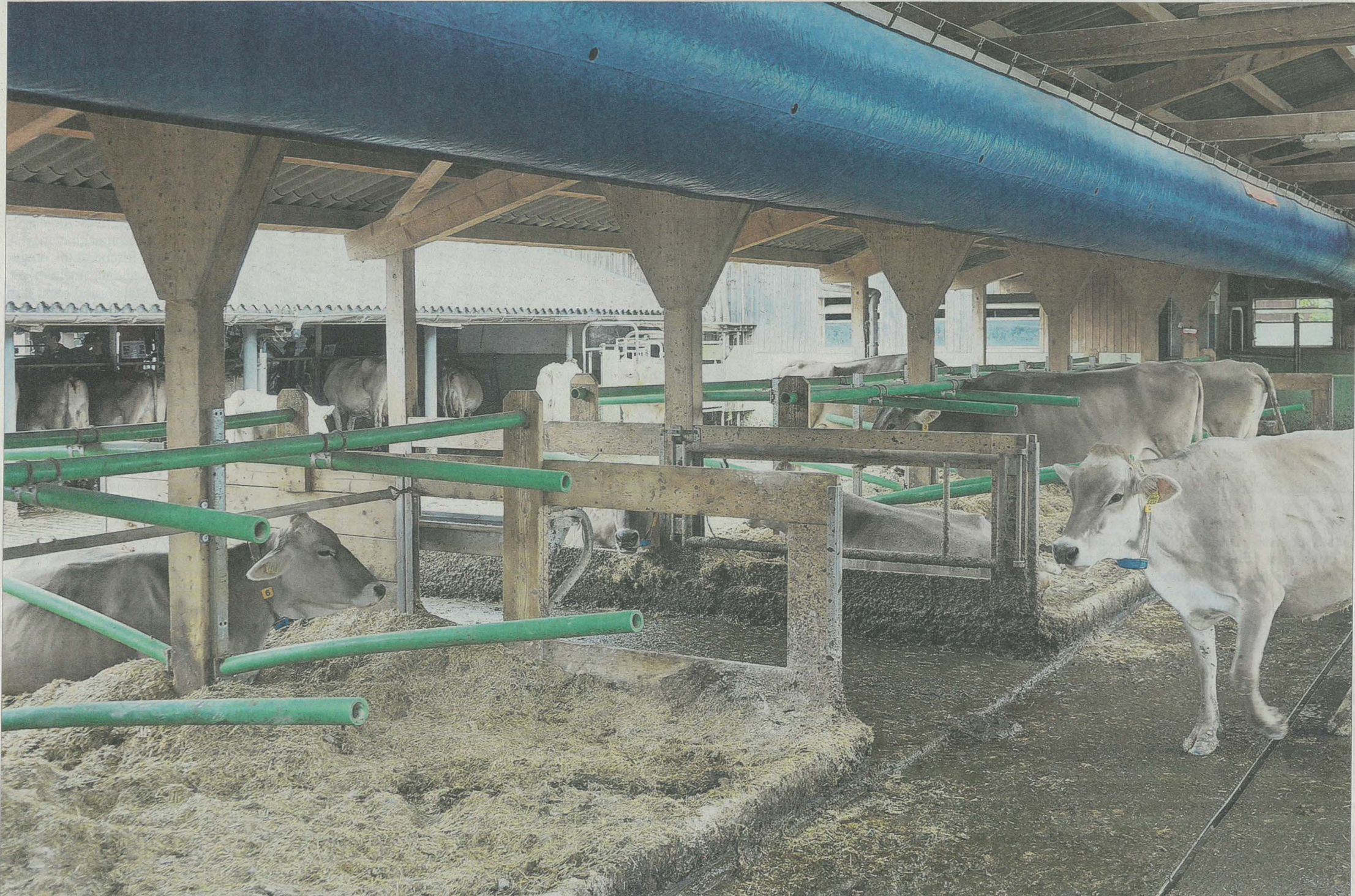
Mit einem Schlauchbelüftungssystem können Kühe in der Liegebox zusätzlich mit frischer Aussenluft versorgt werden. (Bild: Martin Brunner)
