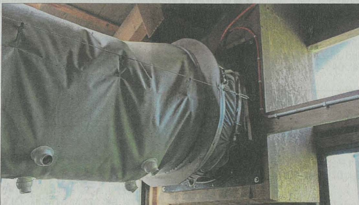
Frischluft wird auf der Westseite angesaugt. Der Betriebsleiter machte die Konstruktion selber.
