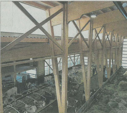
Ein offener Dachschild Richtung Norden bringt gute Luftqualität in den Stall.
