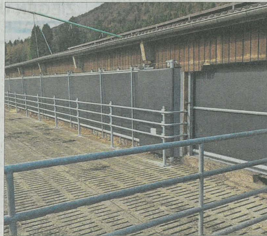
Wand weg – Rollblache hin. Das Stallklima kann dadurch deutlich verbessert werden.
