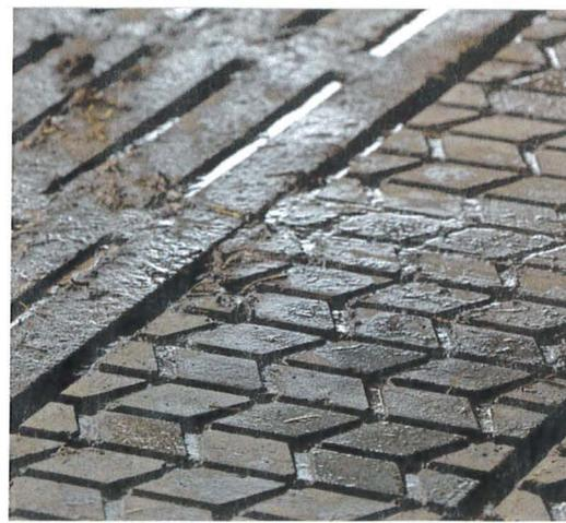
Links die Spaltenböden, rechts die SG-6-Elemente mit den Querrillen. Dank diesen fliesst der Harn rasch ab. Kurt Huber hat vor allem die Rutschfestigkeit überzeugt.
