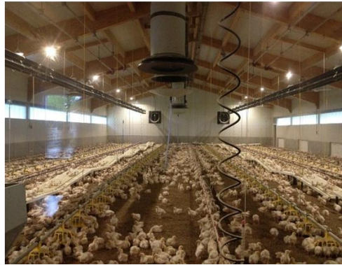
Abbildung 10: LED-Beleuchtung Geflügelmasthalle
