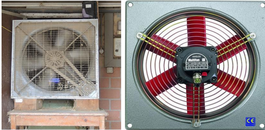
Abbildung 9: Belüftung: schlechtes Beispiel (links), gutes Beispiel (rechts)
