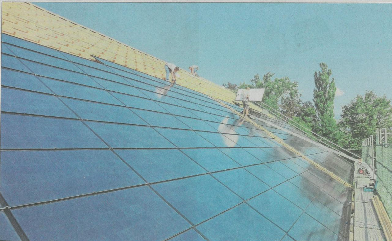
Bei Indachanlagen (auf dem Bild die Neueindeckung eines Scheunendaches) gelten höhere Anforderungen für die Installation als bei Aufdachanlagen.
