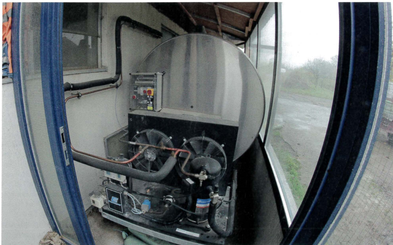
Vom Kühlaggregat führt eine Leitung zur Wärmerückgewinnung. Die Abwärme dient zur Vorwärmung des Wassers im Boiler.
