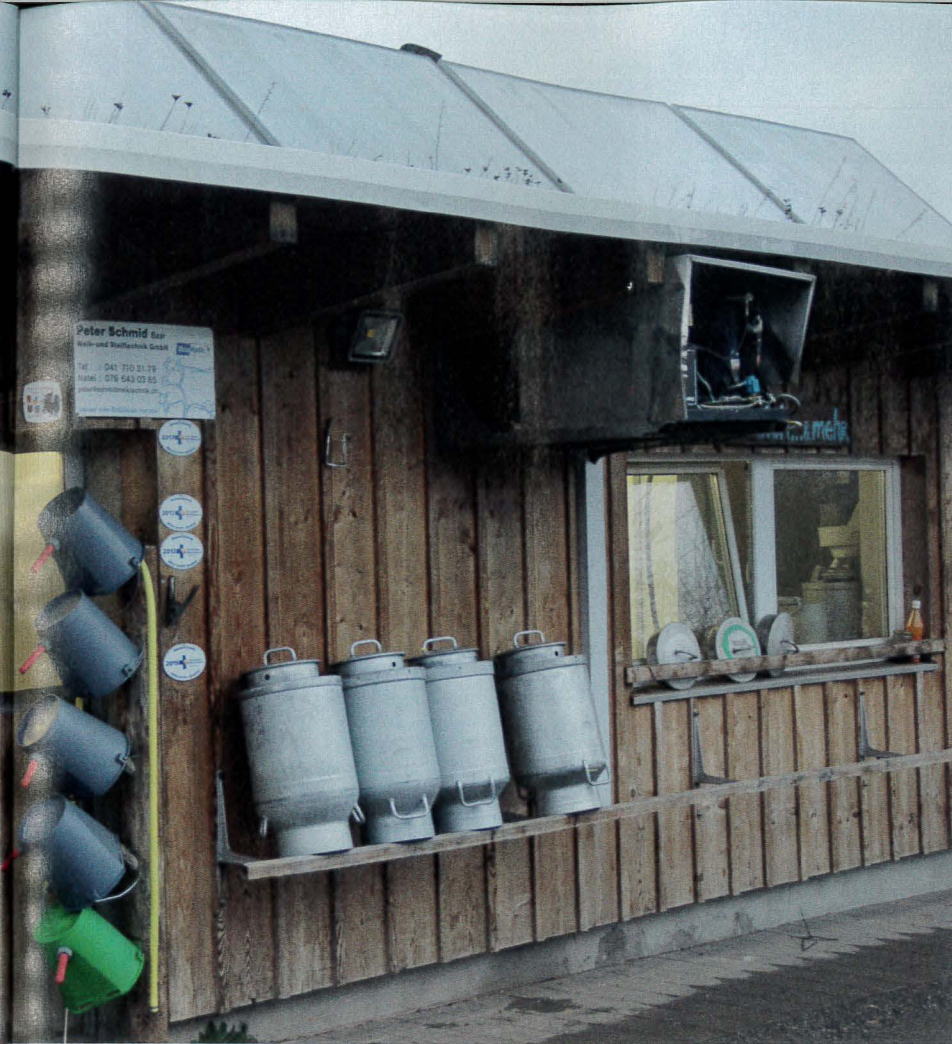
Thermische Sonnenkollektoren wärmen das Boilerwasser vor. Die Kältemaschine zur Milchkühlung ist unter dem Vordach des Milchzimmers installiert.
