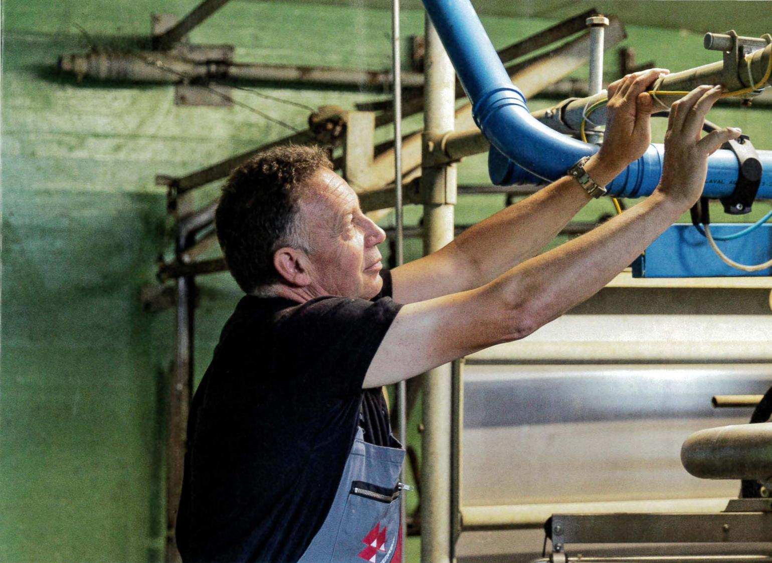
Das funktionierte gut, doch nun floss über den Netzschutzleiter mehr Strom: Nämlich sowohl vom Wohnhaus als auch vom Stall, zum zentralen Erdungspunkt, der Güllegrube. Dabei passierte der Strom den Melkstand.
