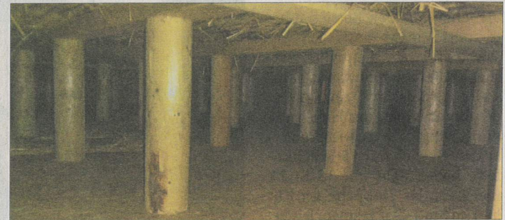
Die Roste sind mit Armierungseisen und Stroh belegt.
