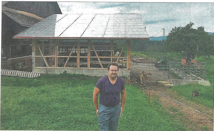
Ueli Steinegger vor seiner Überdachung. (Bilder: zvg)
