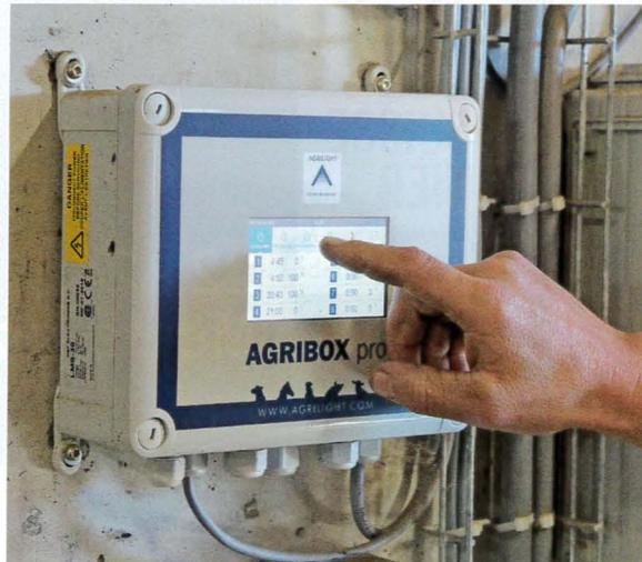
Am Steuergerät wird das Lichtprogramm eingestellt.
