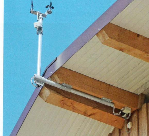
Am Dachfirst messen Sensoren das Licht und den Wind.
