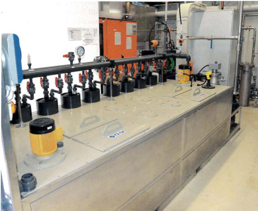
Hier entsteht im Membran-Stripping-Verfahren Flüssigdünger aus Klärschlamm, der in der Landwirtschaft verwendet wird.
