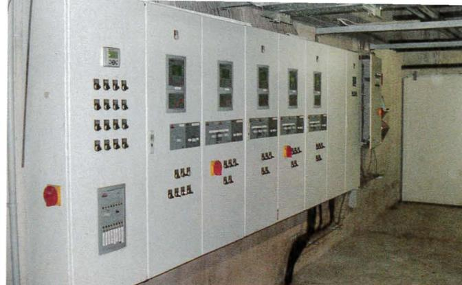
◁ Wenn möglich, sollten die elektrischen Anlagen zentral in einem feuerhemmenden Raum untergebracht werden.
