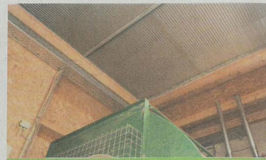
**L'échangeur de chaleur à eau chaude est, ici, installé au plafond.**
