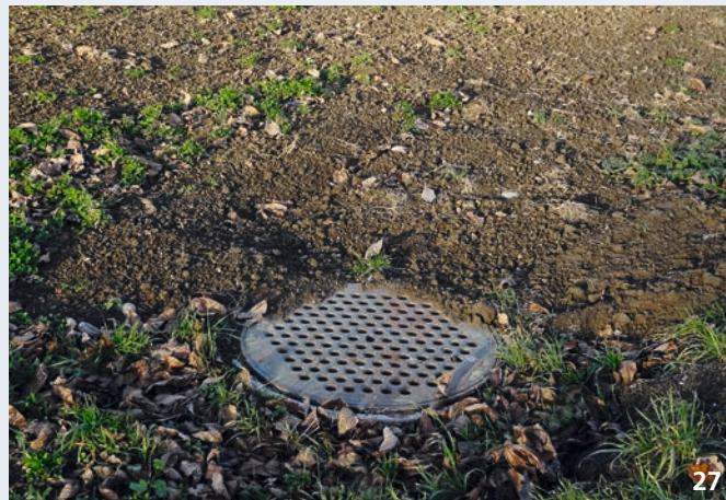
Il n'y a pas de couvercle. L'eau provenant des parcelles et la terre érodée s'y infiltrent.
