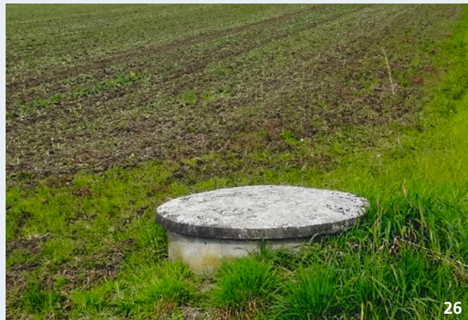
Le couvercle est fermé sans trous ni fissures visibles.
